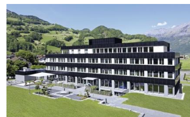
Gute Wärmedämmung, zeitgemässe Gebäudetechnik und eine Photovoltaikanlage machen das nach Minergie-P-Eco zertifizierte Verwaltungsgebäude zum Plusenergiehaus.
