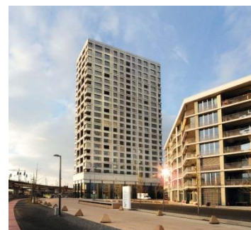
Das Wohnhochhaus Zölly in Zürich wurde als erstes in der Schweiz nach Minergie-Eco zertifiziert. (Bild: Losinger Marazzi)
