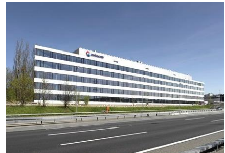
Der neue Swisscom-Businesspark in Ittigen bei Bern dient an der Fachtagung als Anschauungsobjekt. Er enthält sowohl Lowtech- als auch Hightech-Lösungen (Bild: Swisscom)
