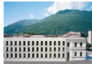
Bundesstrafgericht Bellinzona, Ansicht Ost. Links der neue Anbau, rechts der Altbau.
