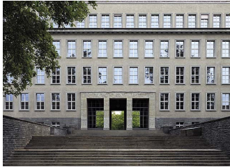
Sanierung Schulhaus Milchbuck, Stadt Zürich (Bild: Stadt Zürich)
