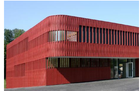
Besichtigung des MINERGIE-ECO Schulhauses Büttenen, Luzern Rohrer Sigrist Architekten Luzern
