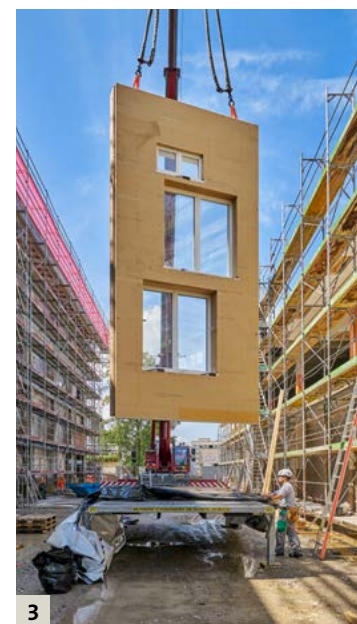
Abb.3 und 4: Das Architekturbüro Insitu lässt Fassadenelemente aus rezyklierten Bauteilen erstellen und auf dem Basler Lysbüchelareal einbauen. © Martin Zeller
