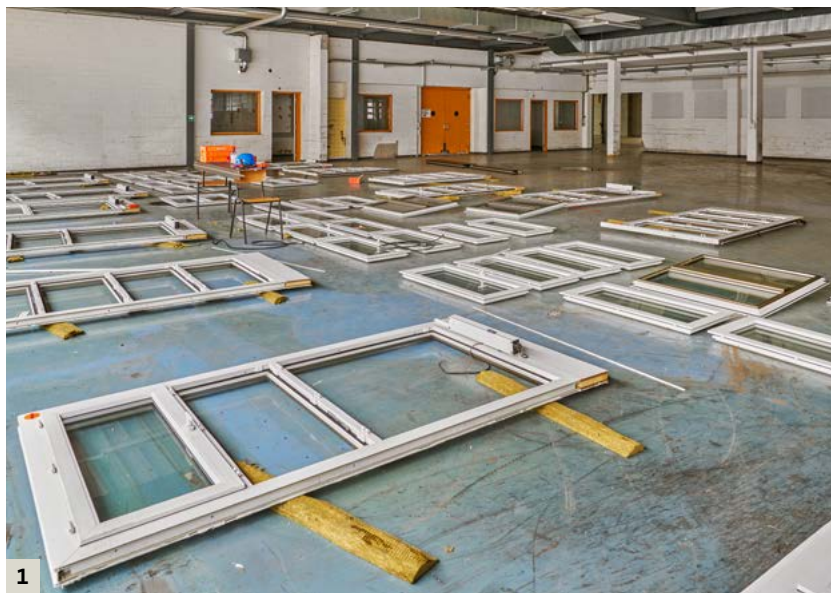
Abb.1 und 2: Rückbau einer ehemaligen Druckerei in Winterthur im Jahr 2018. Die Fassadenteile und Fenster werden vom Basler Architekturbüro Insitu für eine Aufstockung auf dem Lagerplatz Winterthur wiederverwendet.
