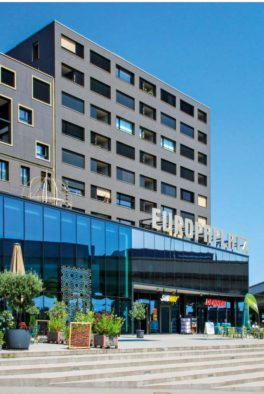
Das 2015 gebaute Haus der Religionen am Europaplatz in Bern beinhaltet in den oberen Geschossen Hotelzimmer und Wohnungen. Die Fassaden sind zweiseitig stark mit Verkehrslärm belastet. Als Schallschutzmassnahme wurden eingezogene Loggias mit geschlossenen Brüstungen gebaut, auf die die Räume gelüftet werden können. Durch die lärmabschirmende Wirkung können die Immissionsgrenzwerte an den darin liegenden Fenster- und Fenstertüren eingehalten werden. (Bild: Gartenmann Engineering AG)
