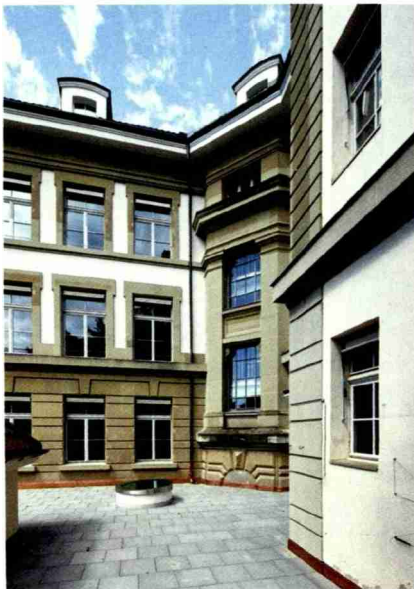
Schulhaus Lorraine Bern, Erneuerung nach Minergie-Eco, 2017.
