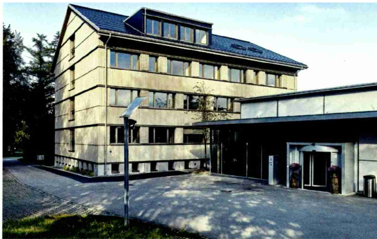
Hauptgebäude WSL Birmensdorf, Erneuerung nach Minergie-Eco, 2017.
