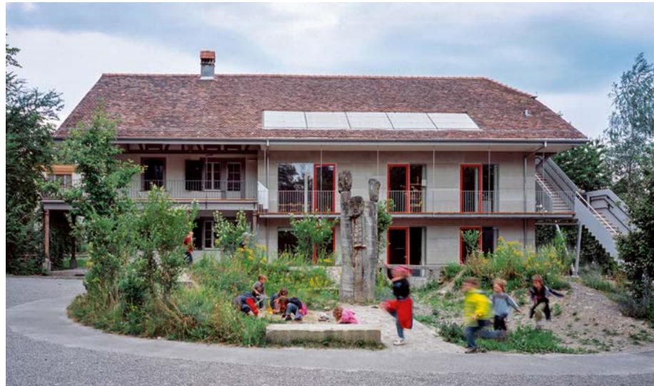
Sanierung Kinderhaus Piccola Bernau, Wabern: Eine neue äussere Erschliessung macht die Räume individuell und variabel nutzbar. Bilder: Christine Blaser
